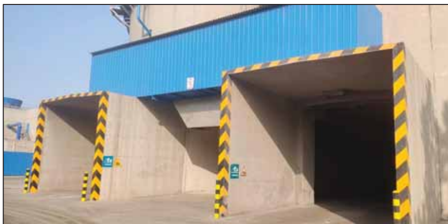
锅炉灰渣暂存及卸料口
