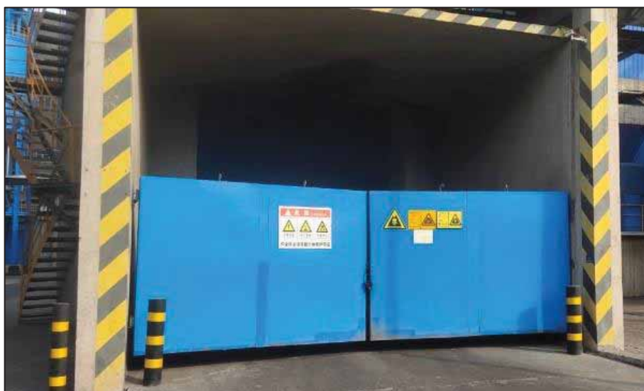
焚烧炉飞灰暂存及卸料口
