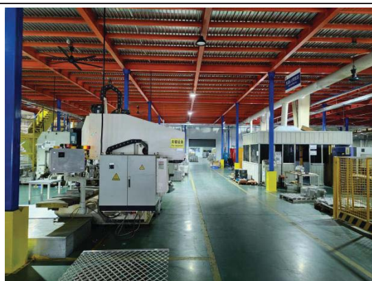
设备拟建设位置东侧焊接区域
