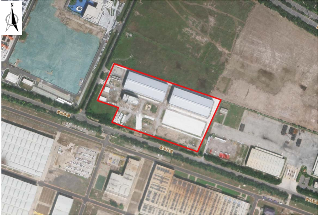
施工过程中（2025 年 08 月）
