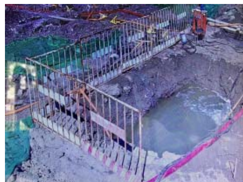
基坑降水沉淀池 (2024.7.20)
