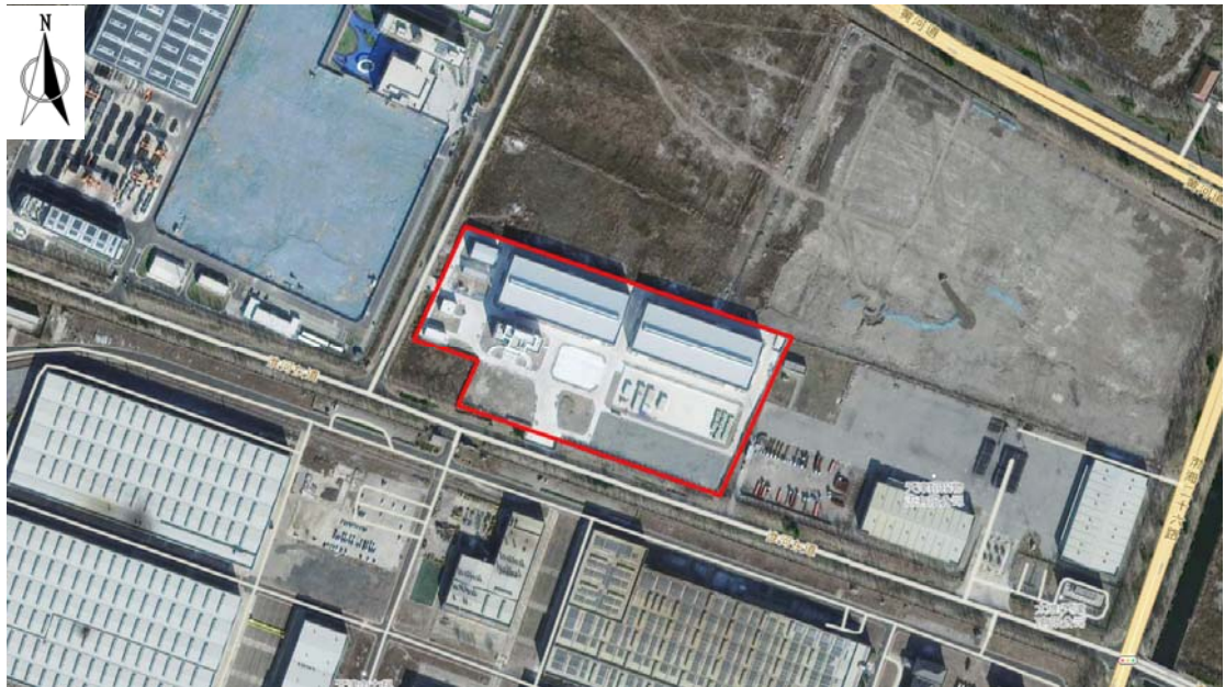
工程完工（2025 年 12 月）
