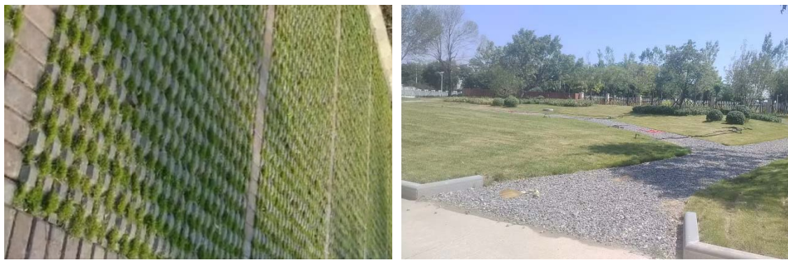
道路硬化工程区-透水砖铺装（2026.6.20） 绿化工程区-下凹式整地（2026.6.20）
