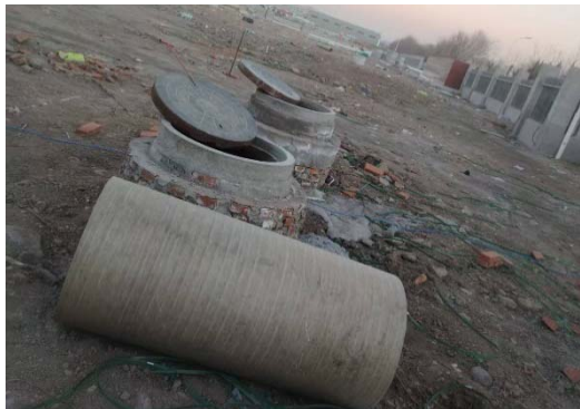
建构筑物工程区-雨水调蓄池（2025.11.16）
