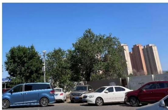
工程终点现状围墙
