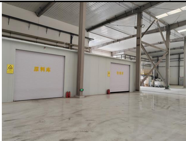
图 4.1-6 原料贮存区现场图
