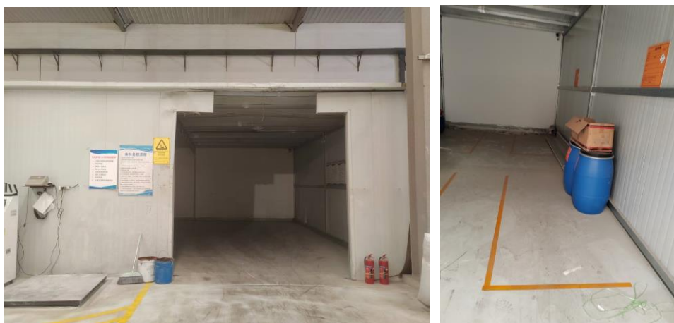
危险废物暂存区
