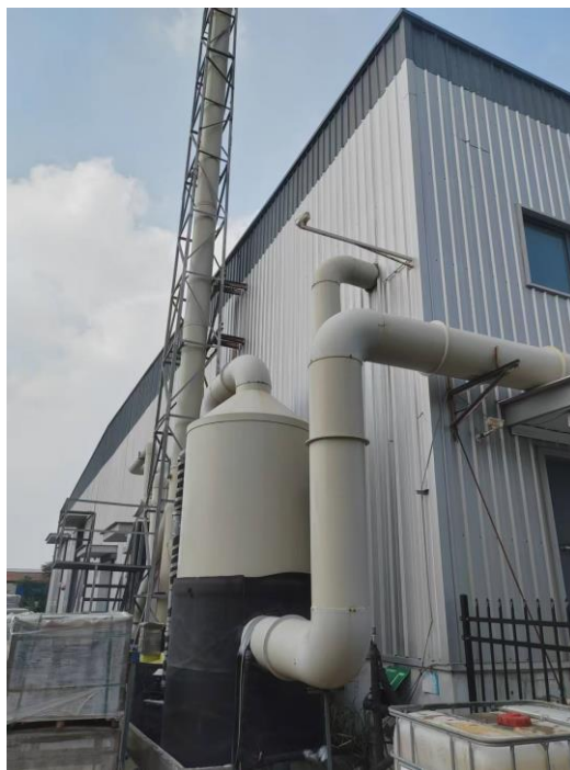
相连的废气治理装置
