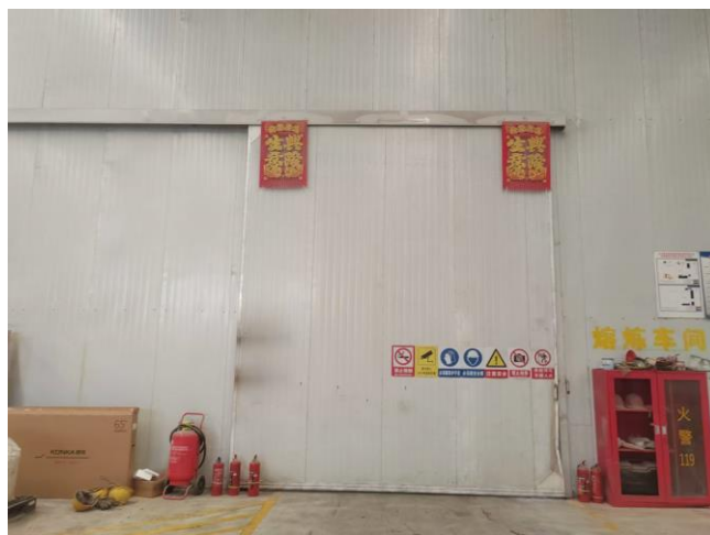
生产区与贮存区之间大门
