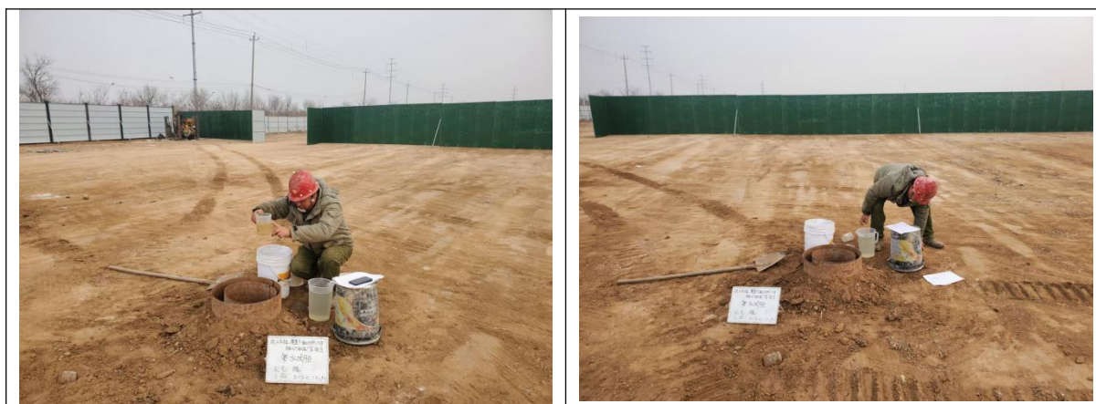
图 3.2-8 现场渗水试验照片
