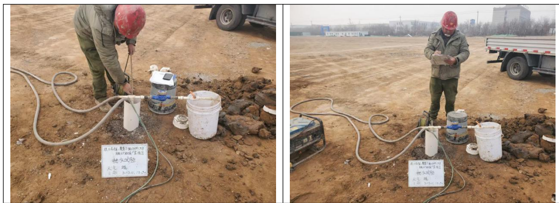
图 3.2-4 抽水试验现场照片
