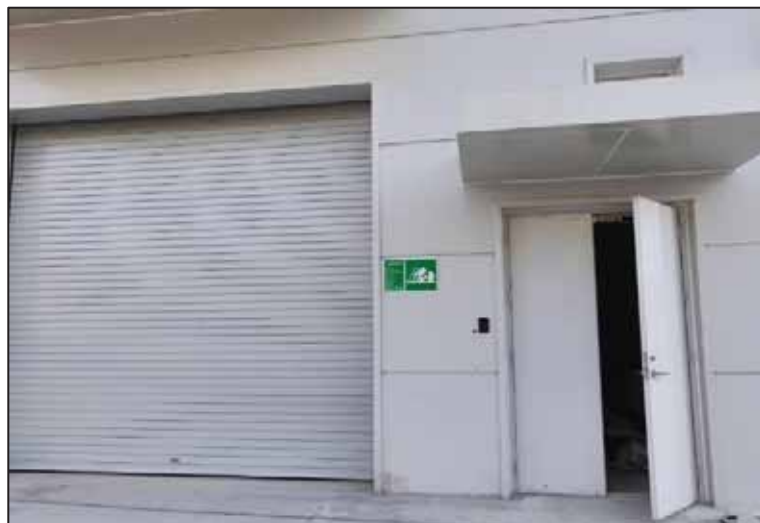
一般固废暂存间
