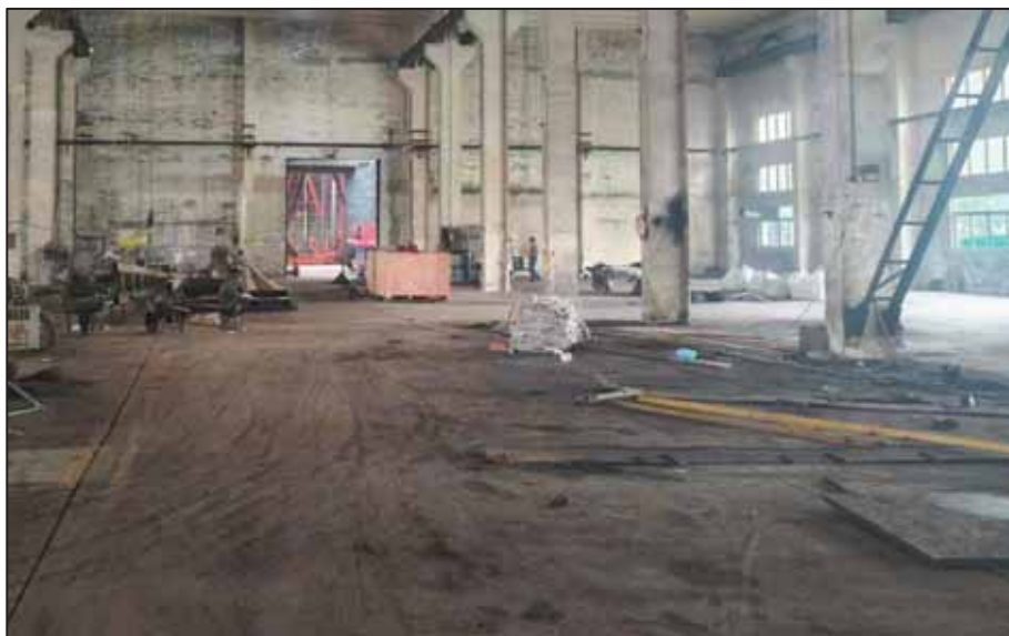
图 2-3 拟建设 CMP 组装及测试生产线处现状图
