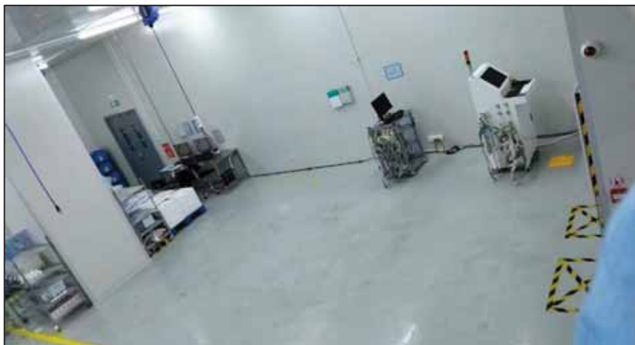
图 2-4 拟建设管路清洗间处现状图
