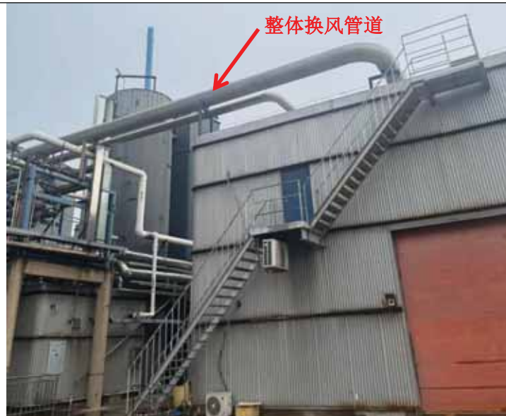
图 2.10-5 卸料间现场照片
