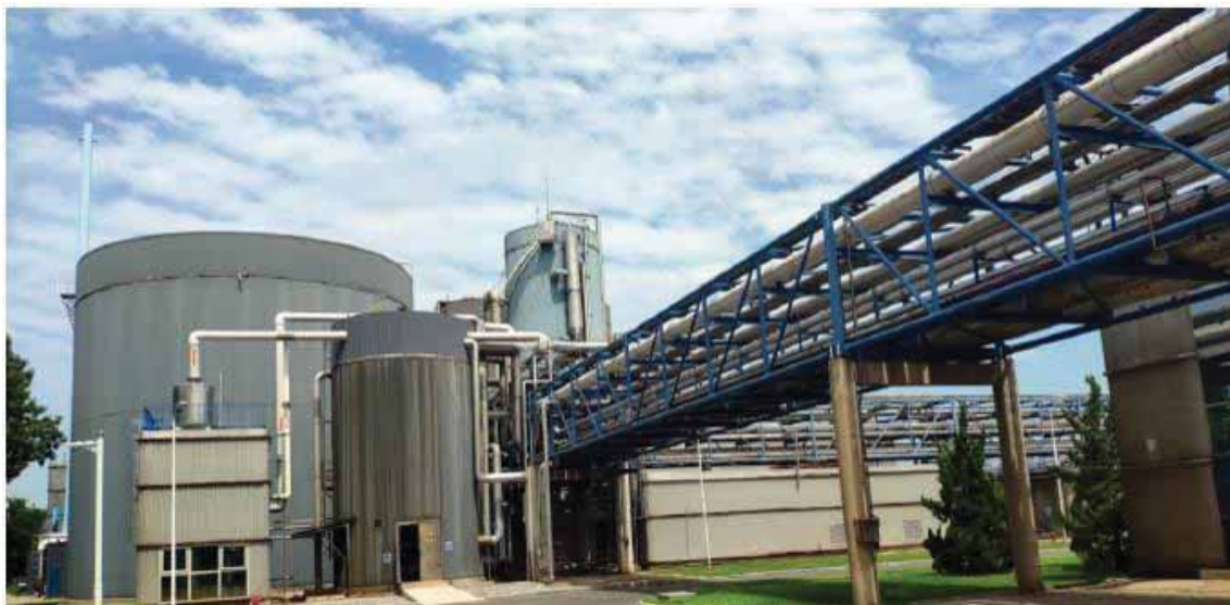
图 2.11-2 现有污水处理站现场照片
