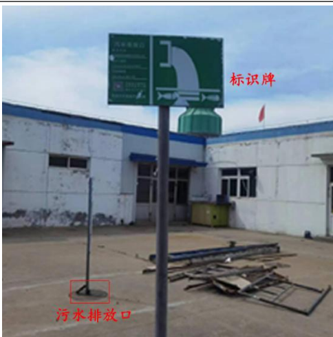
污水排放口 DW001
