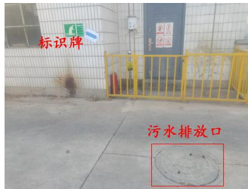
污水排放口 DW002
