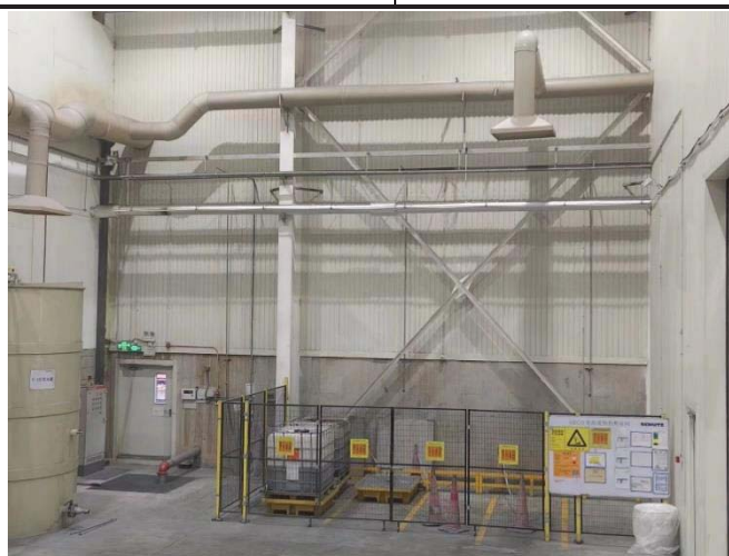
图 3-1 本项目危险废物暂存区（位于回收车间内）
