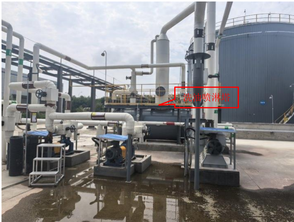
原料油储罐废气收集与治理图
