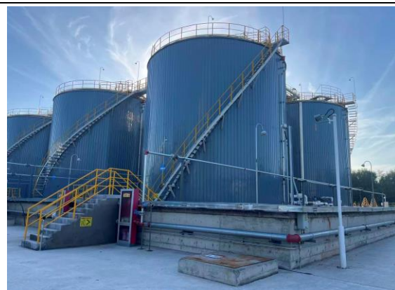
原料油罐区围堰
