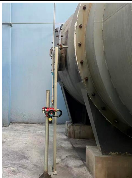
炭黑生产装置及炭黑尾气输送区域一氧化碳监测报警装置
