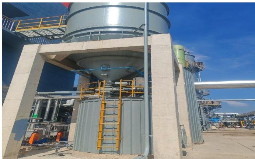
仓顶部布袋除尘器照片如下：
