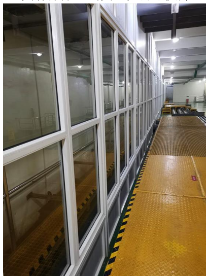
集水井废气整体封闭
