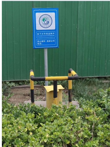
厂区内地下水监测井
