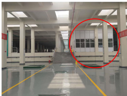
生化反应池组（已封闭）
