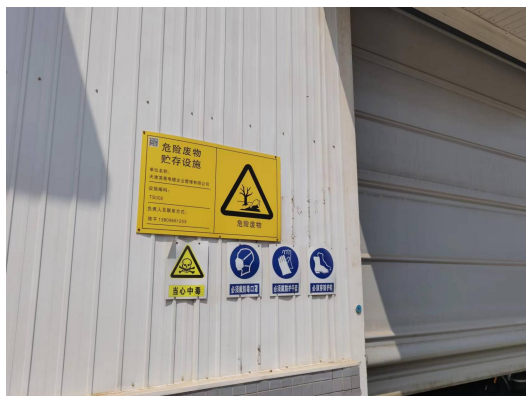
集中式危险废物暂存仓库
