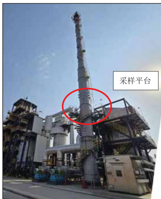
脱臭装置废气排气筒 (DA001)
