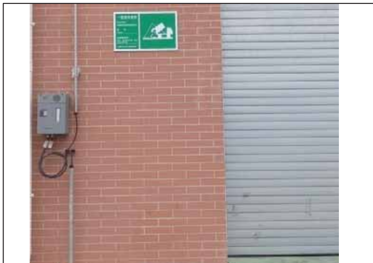
一般固废暂存间
