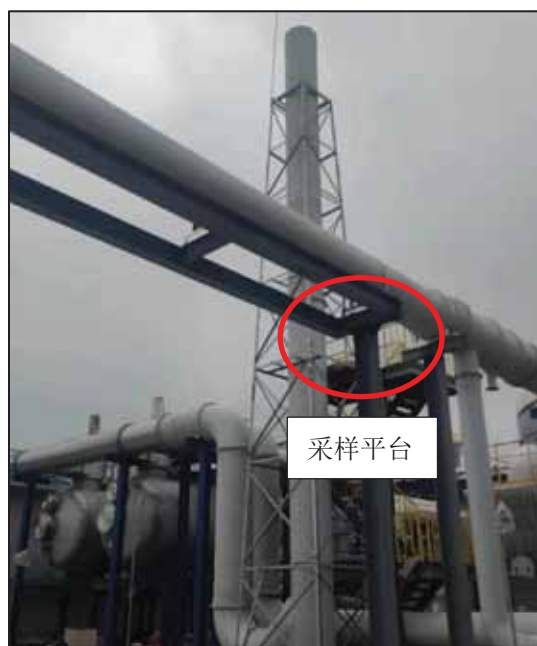
脱臭装置废气排气筒 (DA001)
