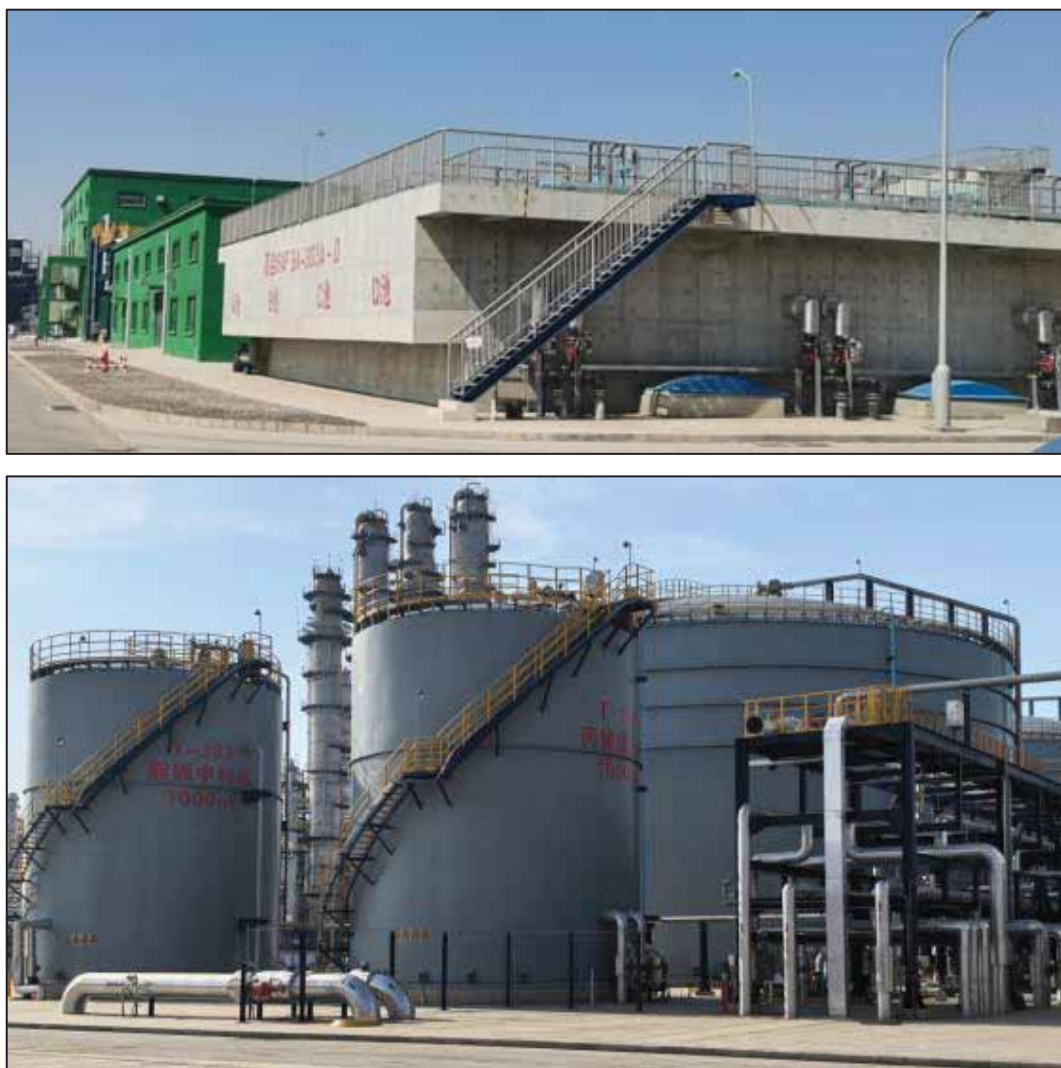
图 4.1-1 废水处理设施实际建设情况图
