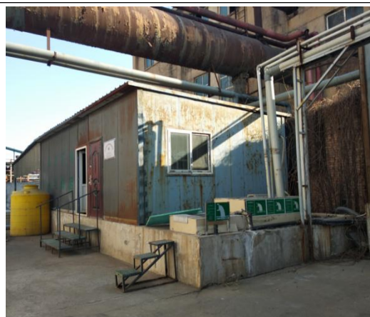
废水总排口及标识牌
