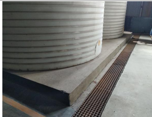
电镀废水处理站四周导流沟
