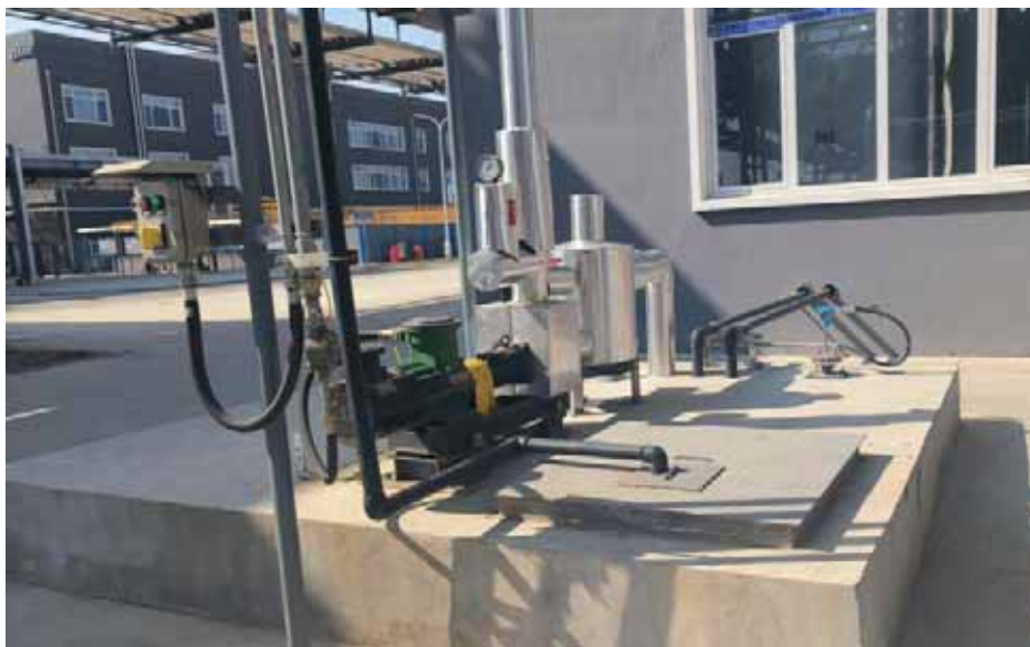
图 4.1-3 甲类厂房 A 配套的废水池
