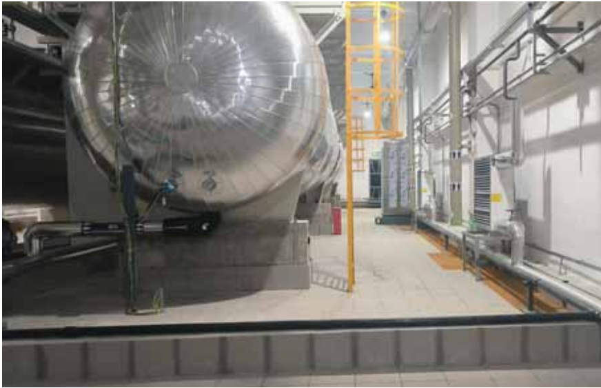
图4.2-2 三氧化硫仓库内防渗地面
