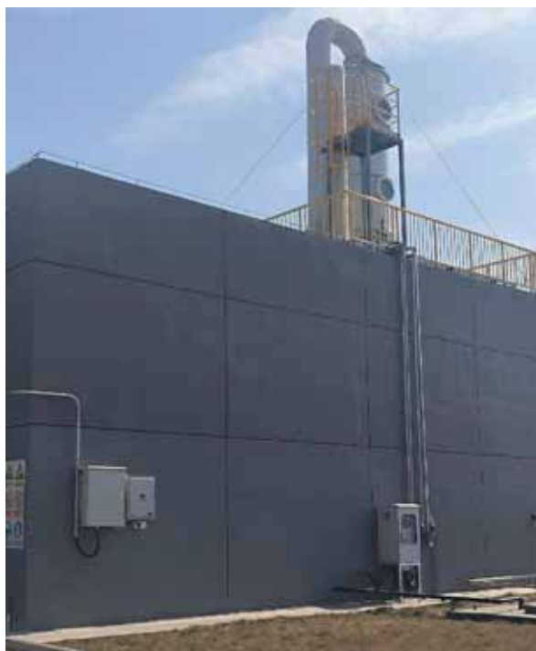
图 4.3-5 三氧化硫仓库的应急喷淋系统
