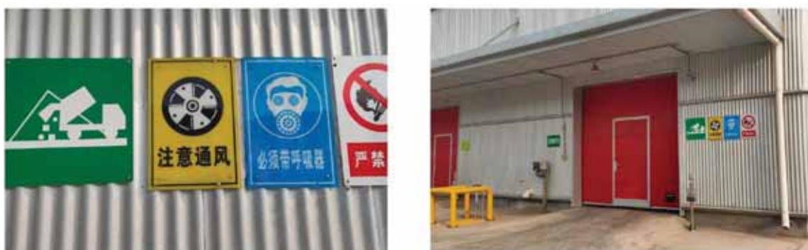
图 2.11-7 一般废物暂存区规范化设置情况
