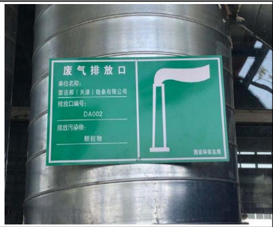
排气筒 P2 环保标识牌
