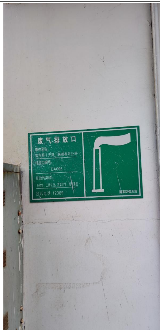
排气筒 P6 标识牌
