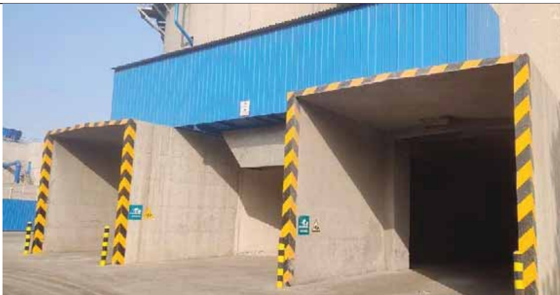
灰渣仓及其卸料口（一般工业固体废物）
