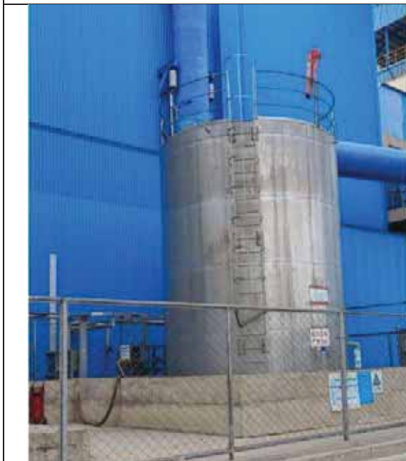
氨水罐围堰
