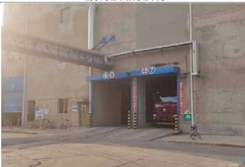
污泥压滤卸料口
