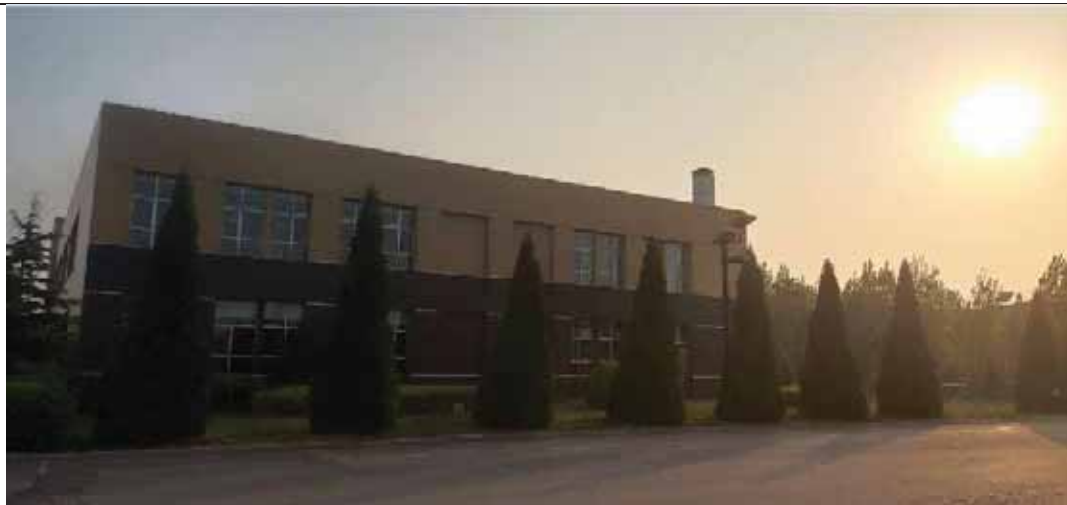
食堂油烟排气筒
