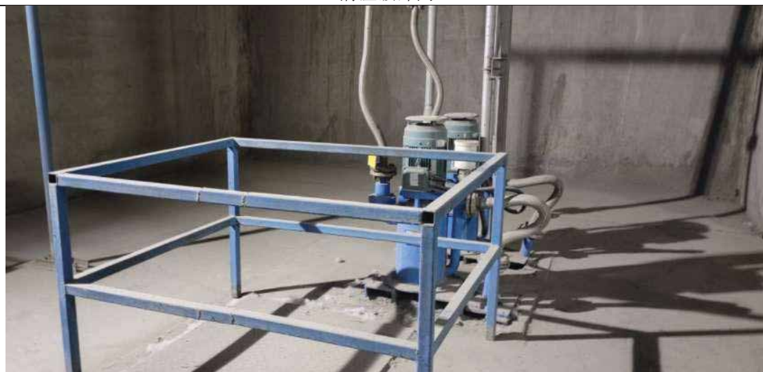
渗滤液收集池（地下）
