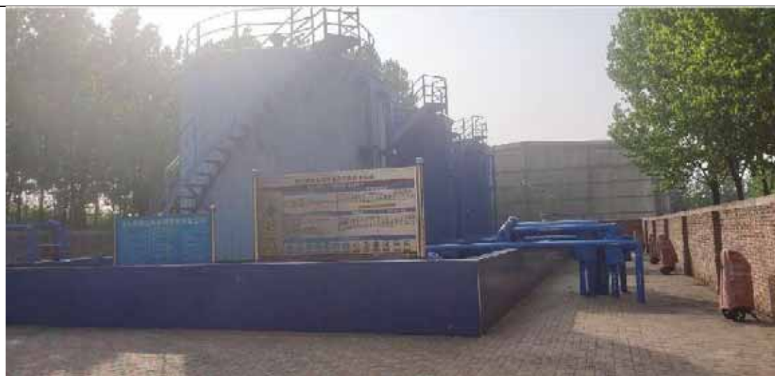
柴油罐区及围堰
