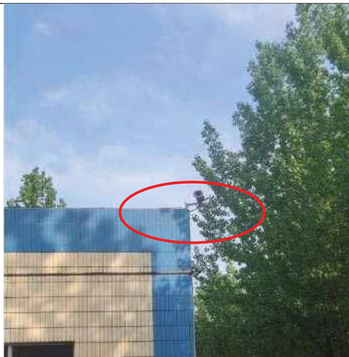
罐区视频监控
