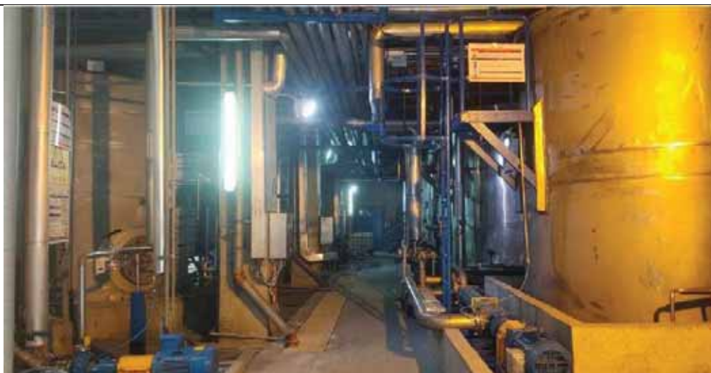
仓储部（液态辅料助剂）围堰
