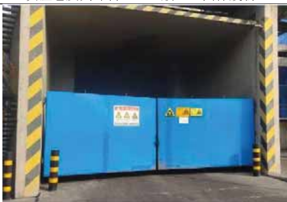
焚烧炉飞灰卸料口（危险废物）
