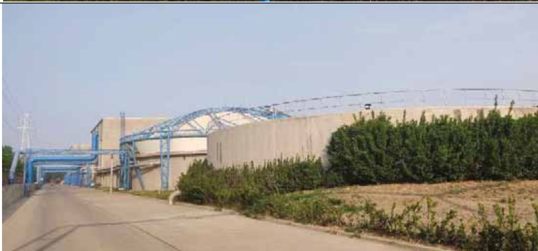
废水处理站各处理单元
