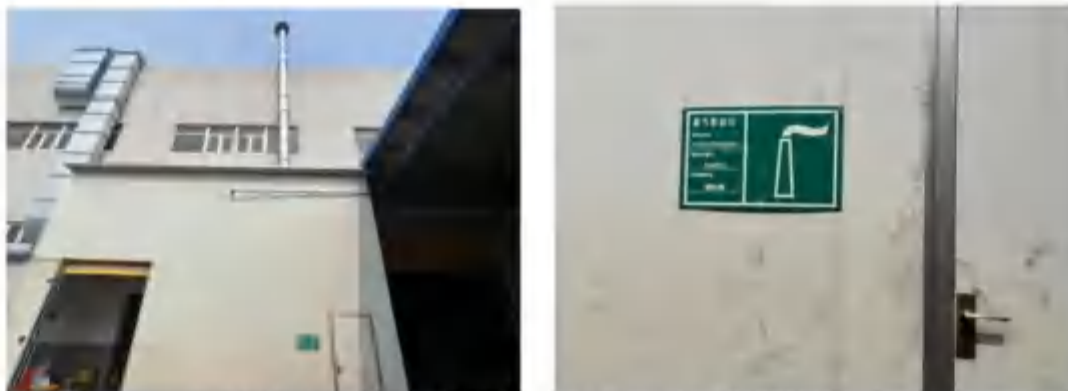
图2.6-1 抛丸工序排气筒（DA001）及其标识牌
