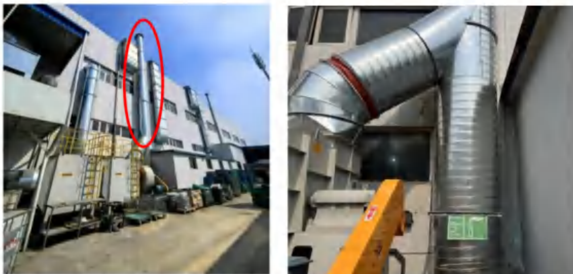
图2.6-3 熔化工序及燃气废气排气筒（DA003）及其标识牌
