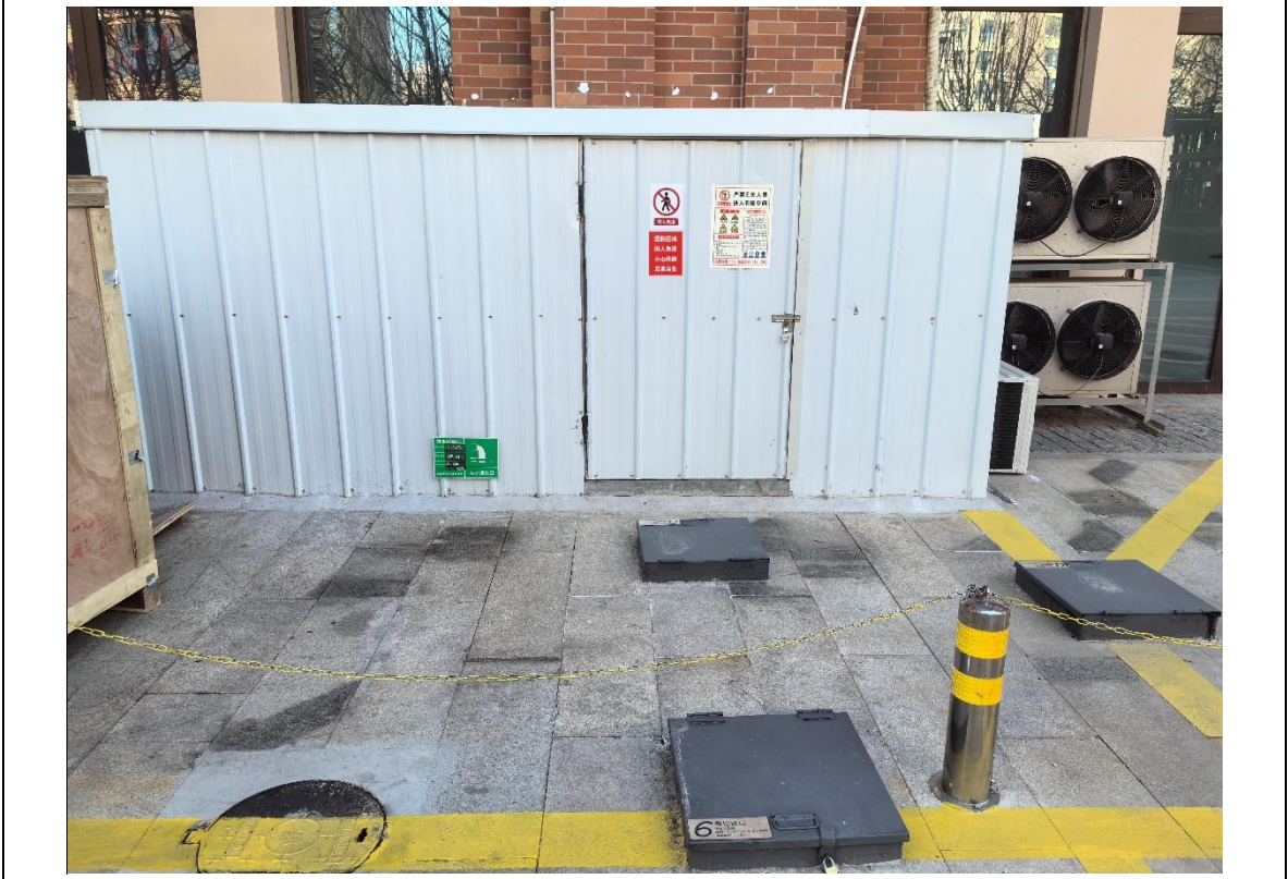
污水处理设施设备间及污水总排口
