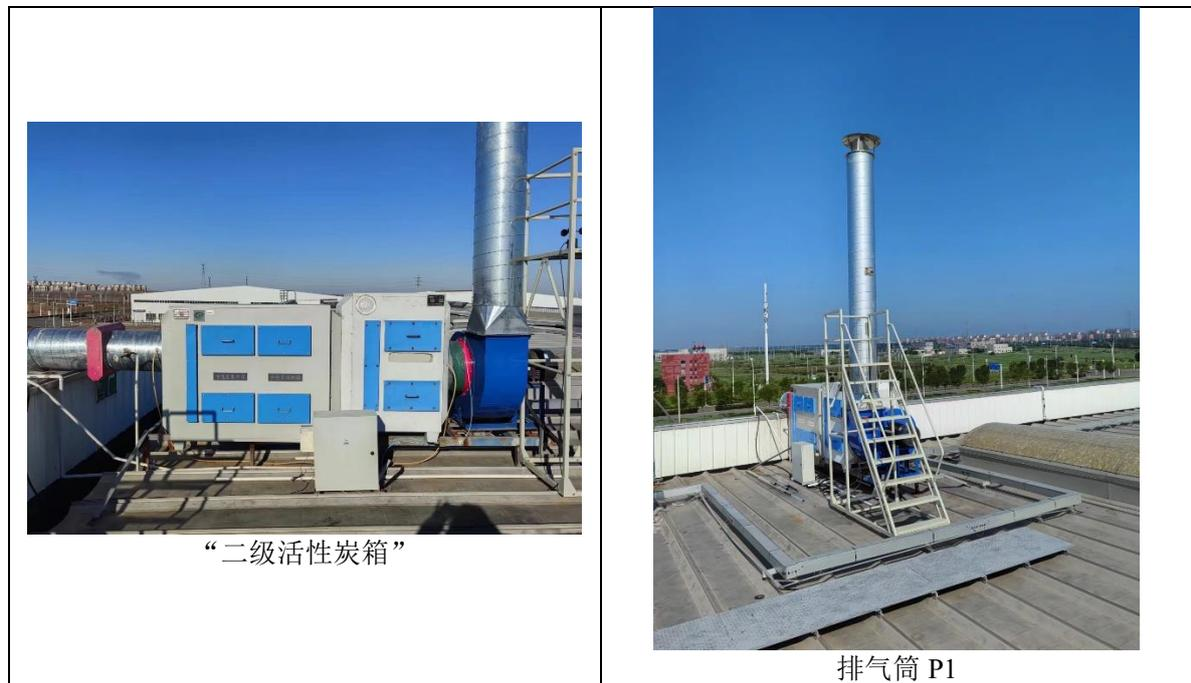
图 3-1 吹塑清洁和吹塑成型废气的处理设施
