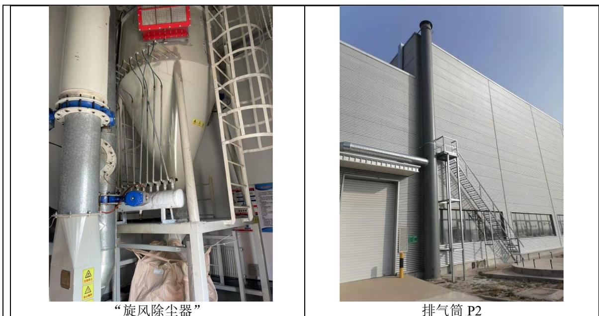
图 3-2 破碎粉尘的废气处理设施
