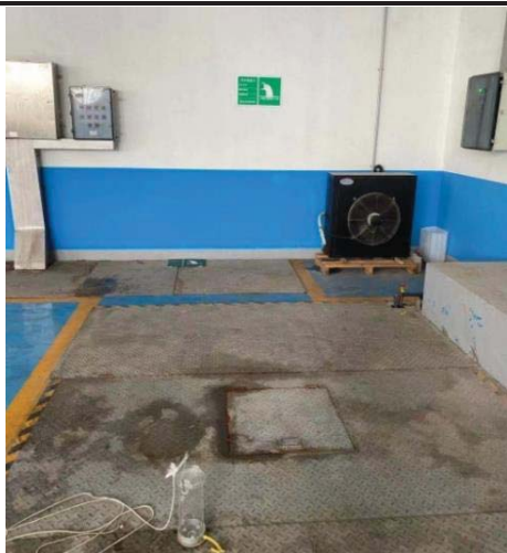
污水总排口 DW001
