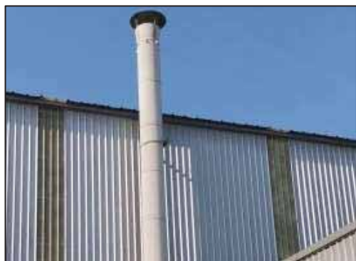
冷轧车间脱脂废气排气筒 (DA009)
