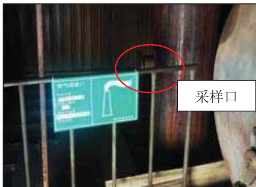
2#导热油炉烟气排气筒 (DA005)
