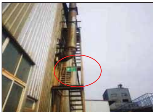
酸洗车间酸洗及盐酸储罐废气排气筒 (DA006)
