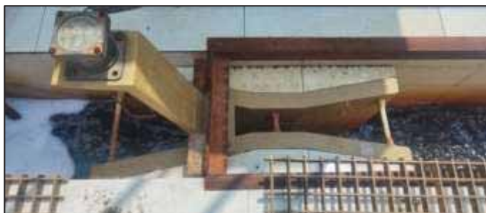
图 2-11 污水总排口规范化
