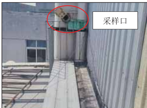
冷轧车间脱脂废气排气筒 (DA009)
