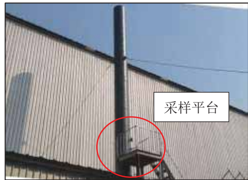
镀锡车间蒸汽锅炉烟气排气筒 (DA011)
