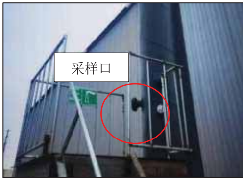
镀锡车间蒸汽锅炉烟气排气筒 (DA011)
