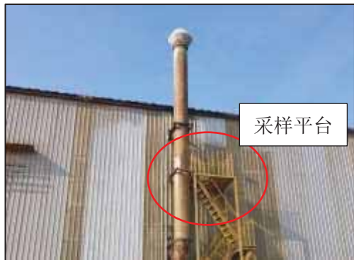
酸洗车间酸洗及盐酸储罐废气排气筒 (DA006)
