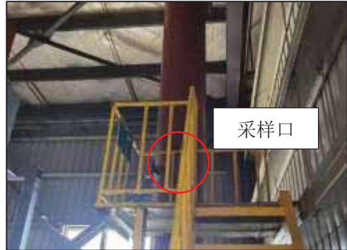
精整车间 1#蒸汽锅炉排气筒 (DA015)
