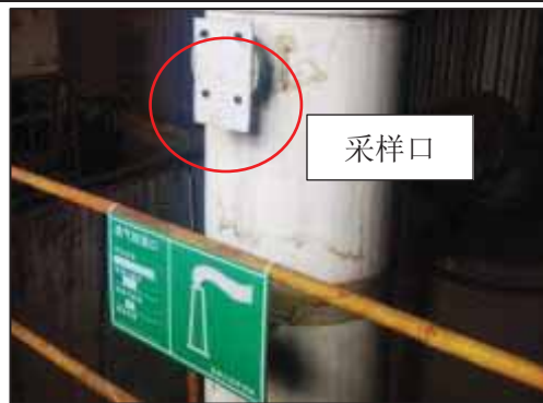
镀锡车间脱脂废气排气筒 (DA002)
