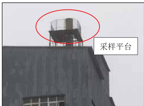
酸再生车间焙烧炉烟气排气筒 (DA008)
