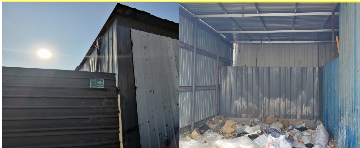
图 4 一般固废暂存间及规范化建设情况
